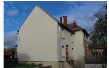
"Les travaux d'isolation par l'extérieur et de ravalement des pignons et de la façade arrière de l'ancien presbytère."
