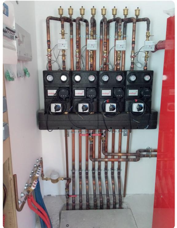
« Tableau de répartition et de commande des circuits au départ de la chaufferie. Des compteurs d'énergie sont placés sur chaque circuit afin de suivre les consommations et évaluer les coûts de chauffage ».
